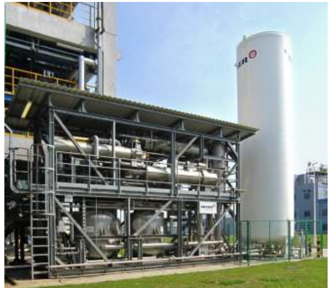
Zariadenie pre spätne získavanie metylchloridu pomocou kvapalného dusíka
